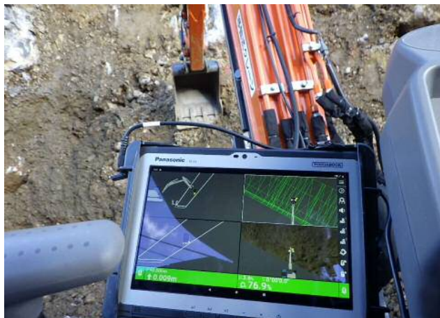
道路改良工事 コンクリート二次製品の据え付け
