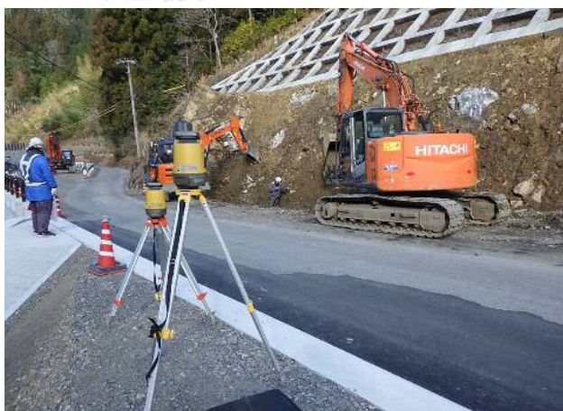
杭ナビショベル及び快測ナビの並行使用による施工例
