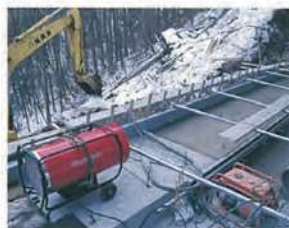
ダクトタイプヒーター使用方法 (ダクトの折れ曲がりにご注意ください)
