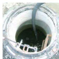
下水道切替工事
